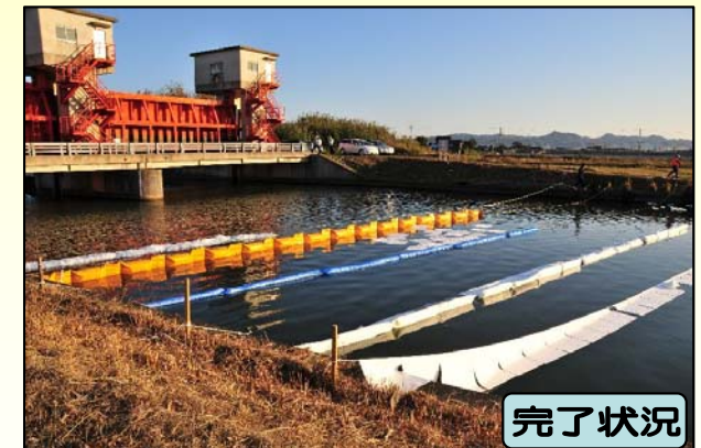
島根県職員によるチューブ型吸着フェンス（スカート付）の展張と吸着マットによるオイルの回収訓練
