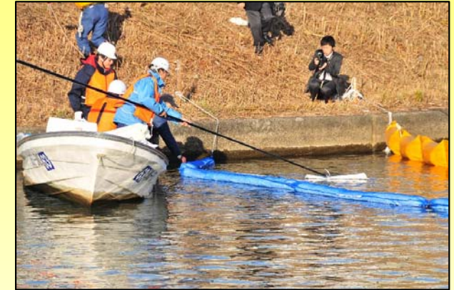
島根県職員によるチューブ型吸着フェンス（スカート付）の展張と吸着マットによるオイルの回収訓練
