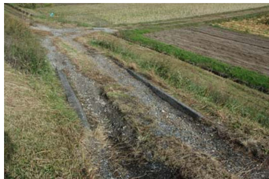
堤防坂路の路面が荒れている
