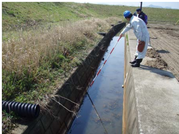
ブロック積擁壁の沈下の有無等確認状況
