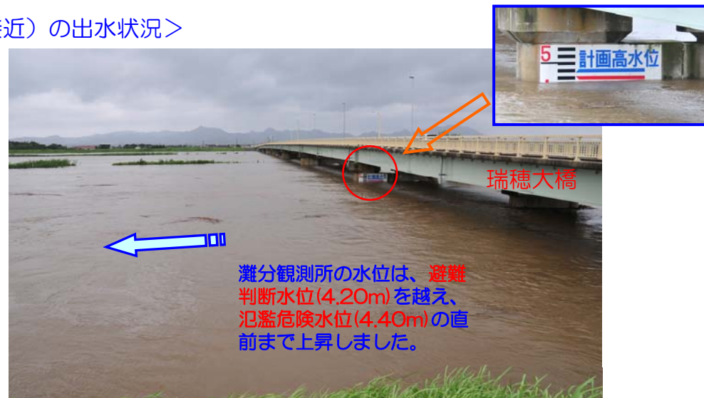
斐伊川左岸4k100付近(対岸を望む)
