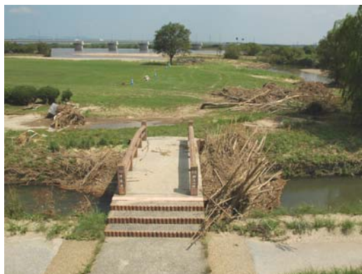
斐伊川左岸12k200付近(神立公園付近)
