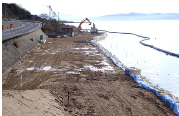
工食用道路設置と川砂投入作業の施工状況
