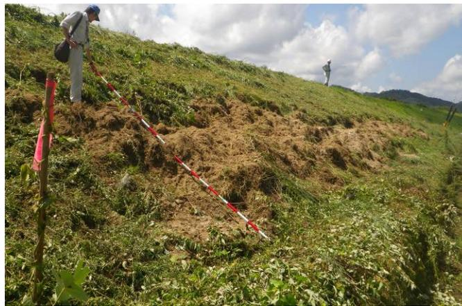
1/3による掘り返しと思われる堤防法面の損傷
