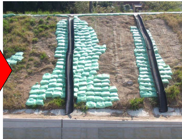
点検を受けて補修した堤防法面
