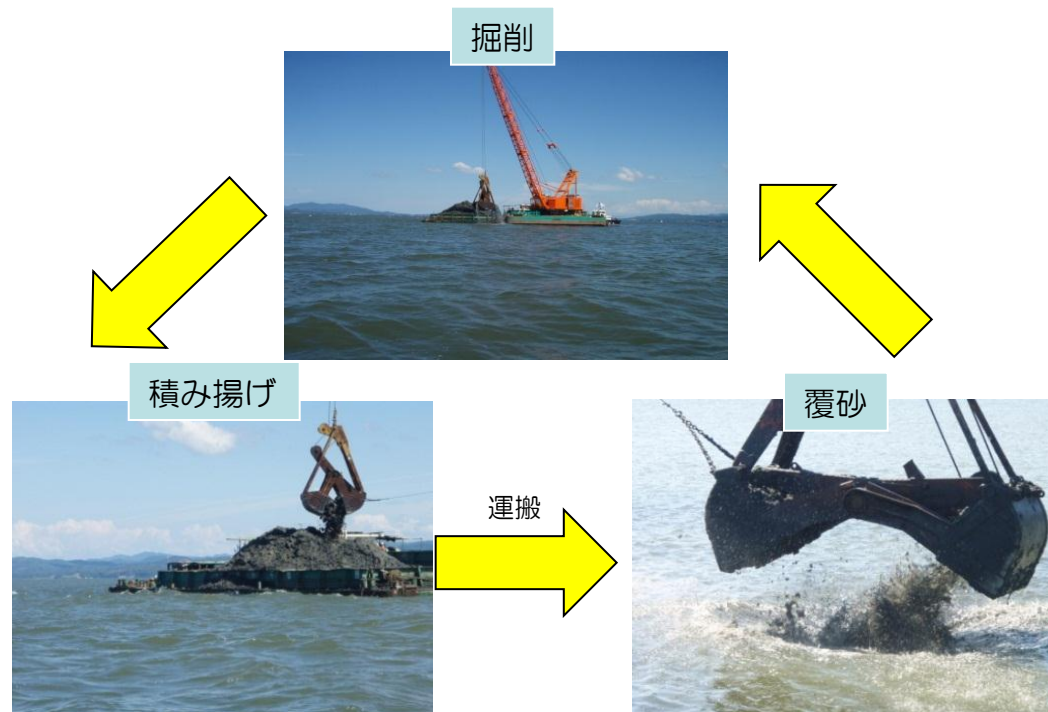
斐伊川河口掘削工事の施工イメージ
