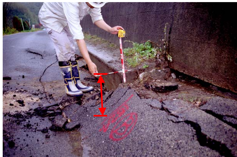
↑ 堤防が最大40cm沈下
