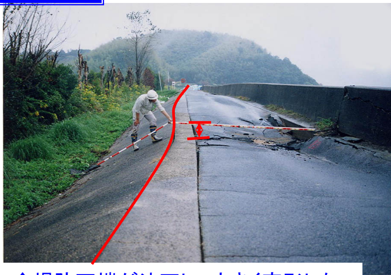
↑ 堤防天端が沈下し、大きく変形した。
