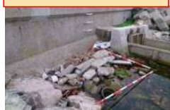
ヒューム管、 コンクリートの投棄
