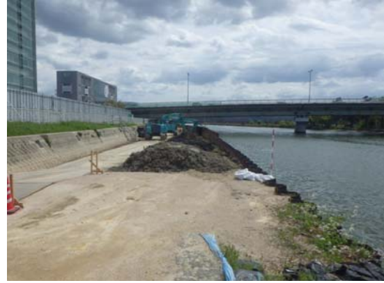
向島地区築堤護岸第3工事
