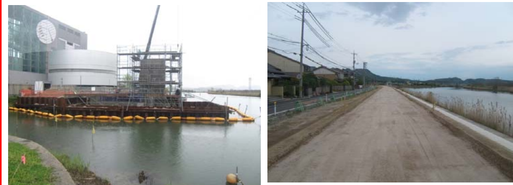
上追子川水門新設外工事
