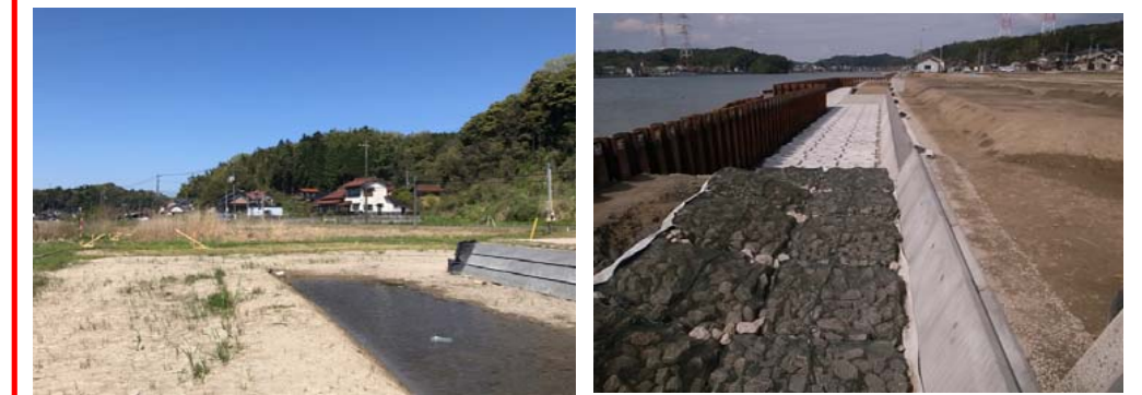
福富上流地区外築堤護岸工事
