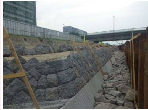
向島地区築堤護岸第3工事
