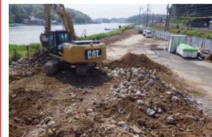
東津田地区護岸外整備工事
