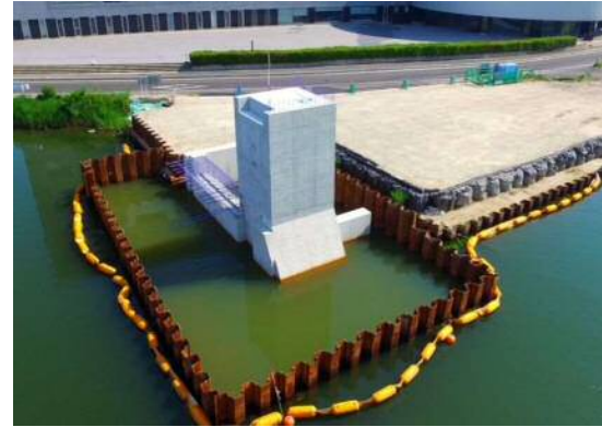
上追子川水門新設外工事
