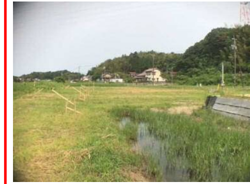
福富上流地区外築堤護岸工事
