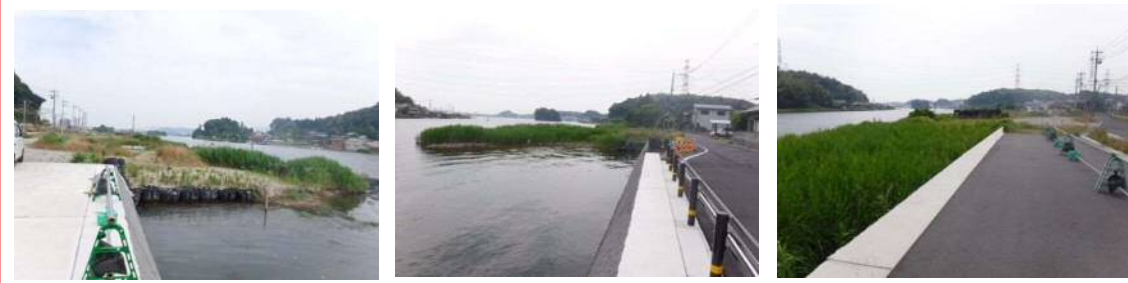
矢田地区第2築堤護岸外工事
