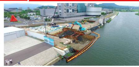
【工事内容】吐出水槽・吐出函渠・護岸施工 【進捗状況】土留・締切工の施工が完了し、床堀作業を行っていま す。
