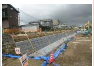
【工事内容】護岸・根固め施工 【進捗状況】河川土工(掘削:写真左)、護岸工 (プロック積み:写真右)の施工を行って います。
