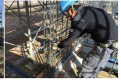
【工事内容】排水機場上屋施工 【進捗状況】壁部配筋が完了し型枠設置を行います。
