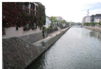
写真1 カラコロ広場前京橋川護岸
