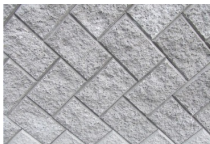
■素材1-1 ・表面が石材に近い質感のコンクリートブロック ・表面にざらつきや凹凸があり明度が低い。
