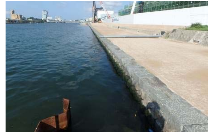
天端石による天端処理（松江地方合同庁舎前）
