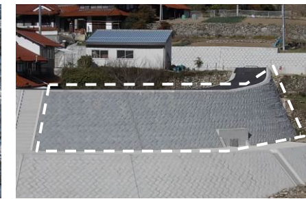
写真2：遠景（広島県太田川） 製品は写真1と同じ
