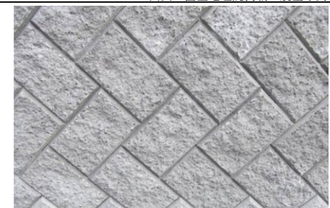
■素材1-1: 従来型の景観配慮タイプのコンクリートブロック 表面にざらつきや凹凸があり明度が低い。
