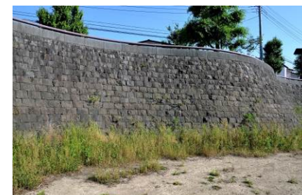
写真14 練石積：深目地仕上げ
