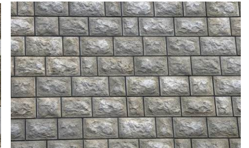
写真3：大型ブロックの事例 （コブ出し仕上げ、明度6.0）
