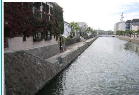
写真1 カラコロ広場前京橋川護岸
