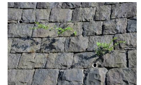
写真15 練石積：深目地仕上げ（同左）
