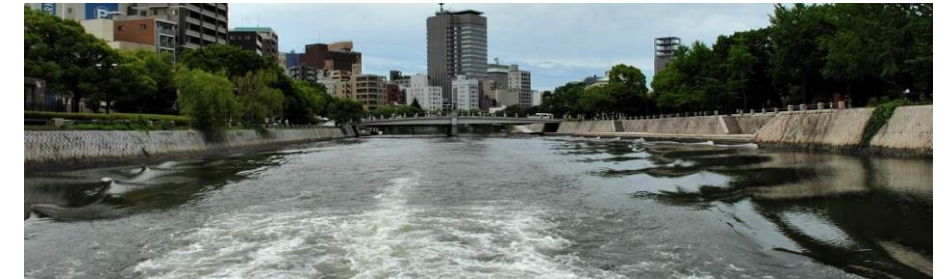
写真5 太田川(広島市)。写真右は階段によって護岸が分節され、景観的なメリハリがきている。写真左は一般的な護岸が連続している。
