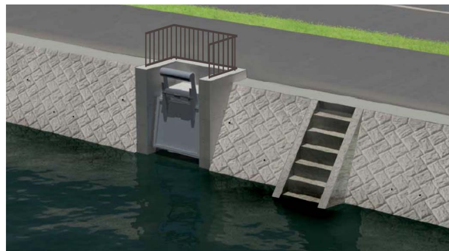
図6 樋門施設等の管理用階段工
