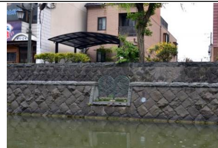
■素材2: 自然石(安山岩系を基本とする) 京橋川・カラコロ広場付近の安山岩護岸。
