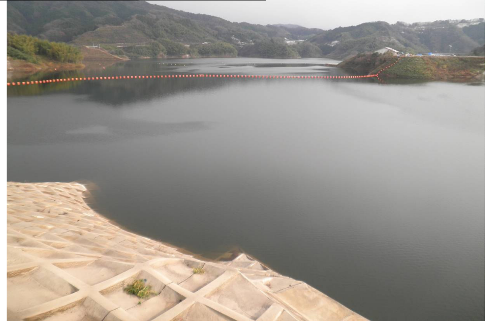
ダム右岸側から上流を望む
