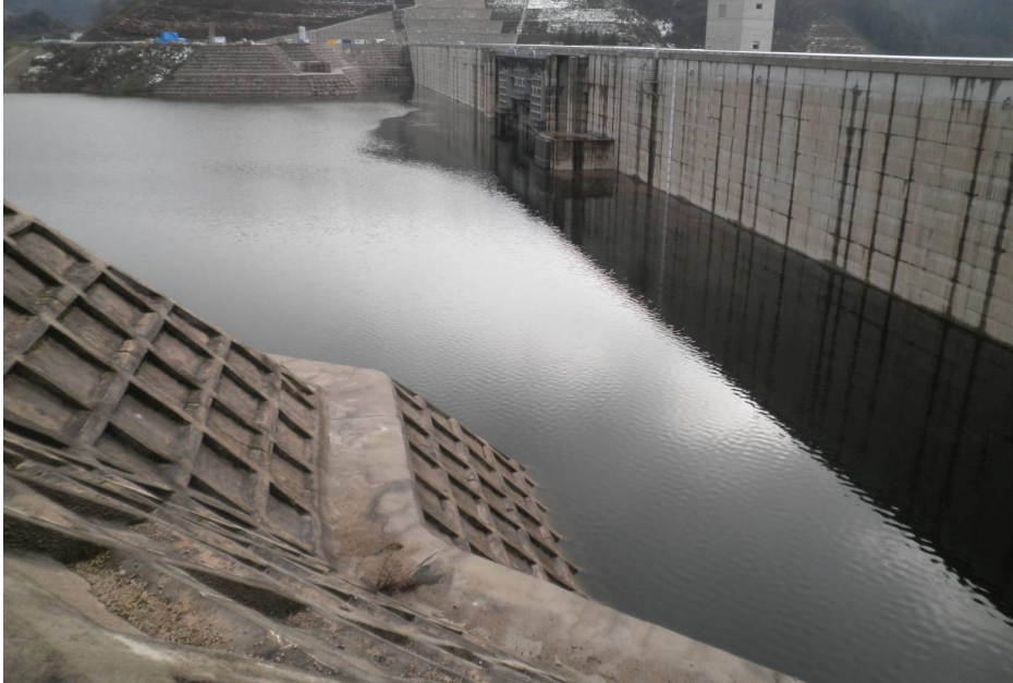
ダム右岸側からダムを望む
