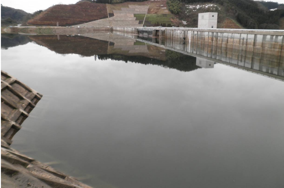
ダム右岸側からダムを望む
