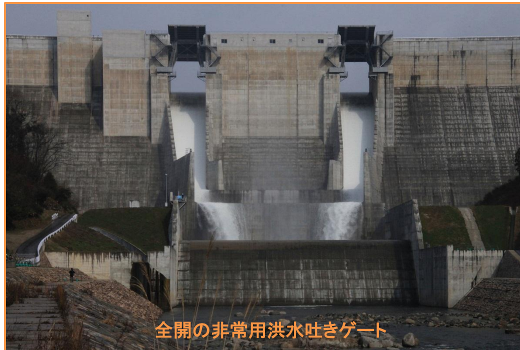
ダム堤頂部から見たラジアル式非常用洪水吐きゲート
