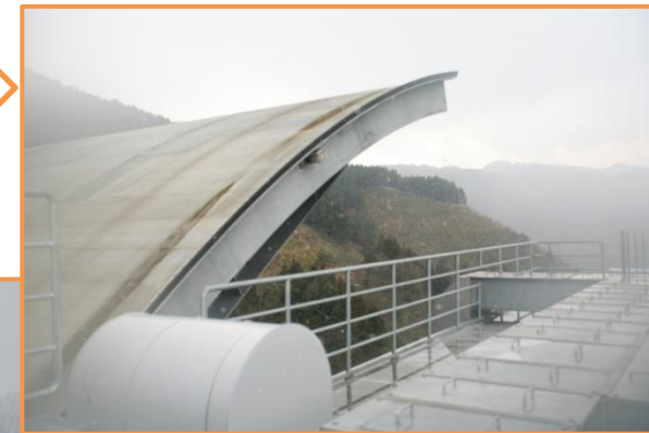
ダム堤頂部から見たラジアル式非常用洪水吐きゲート
