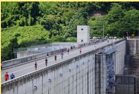
ランコースは尾原ダムの堤頂を走ります!
