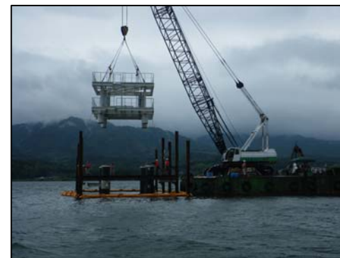
建設中の様子
