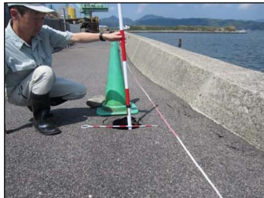
出水（波浪）による吸出して陥没した管理道
