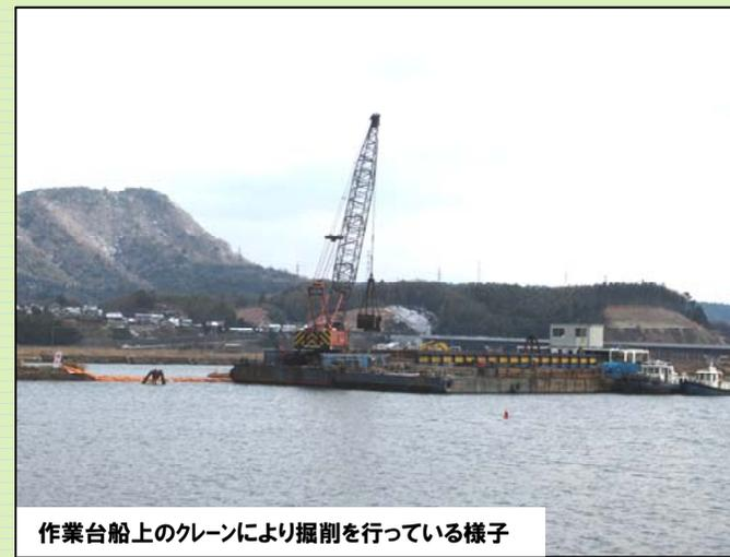
作業台船上のクレーンにより掘削を行っている様子
