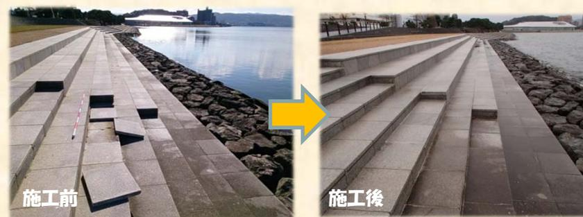
●(大橋川)くにびき大橋下の護岸背面の吸出し
