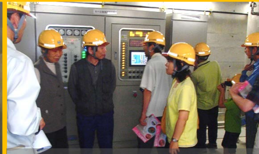
ダムの中（取水設備室）の見学
