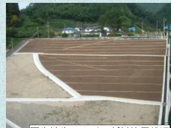
再生植生マルチング材使用状況
