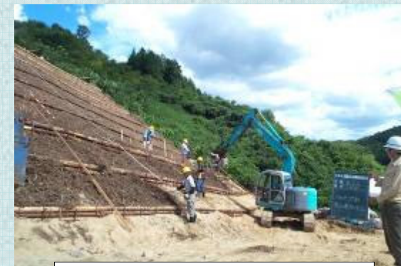
再生植生マルチング材使用状況
