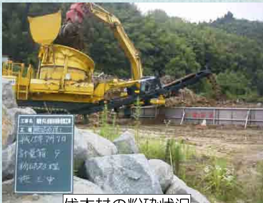
伐木材の粉碎状況
