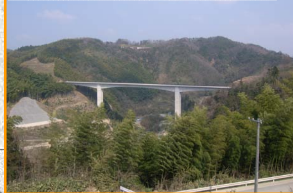
尾崎山方線1号橋 (H21.3完成)
