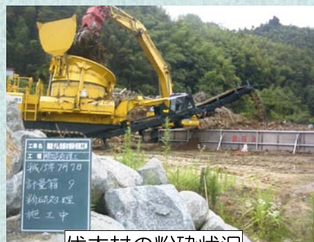
伐木材の粉碎状況
