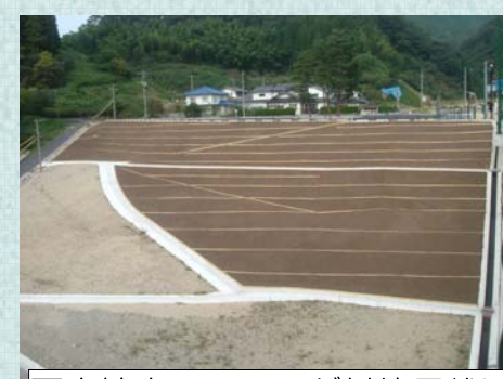
再生植生マルチング材使用状況
