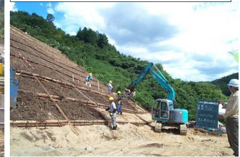
再生植生マルチング材使用状況
