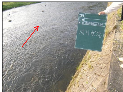
横見警報所付近の神戸川の状況
