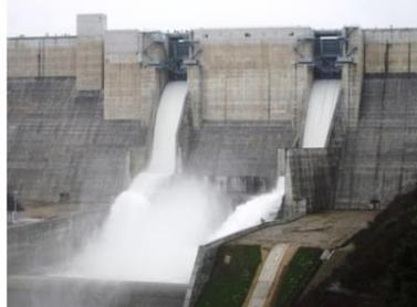
■平成24年3月 洪水時最高水位到達後の非常用洪水吐きからの試験放流状況
