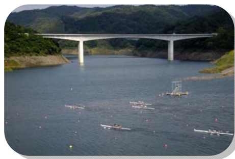
「祝ボート施設竣工」※
