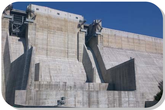
尾原ダム本体の活用（堤高約 90m）
