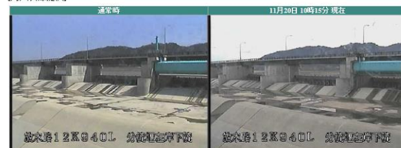
ライブカメラ（分流堰左岸下流）
