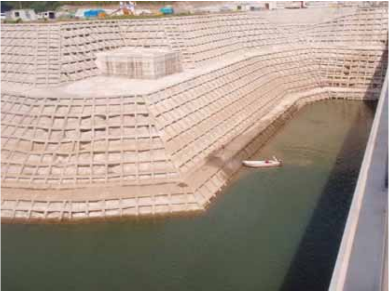
船上調査状況（左岸堤体直上流法面）
