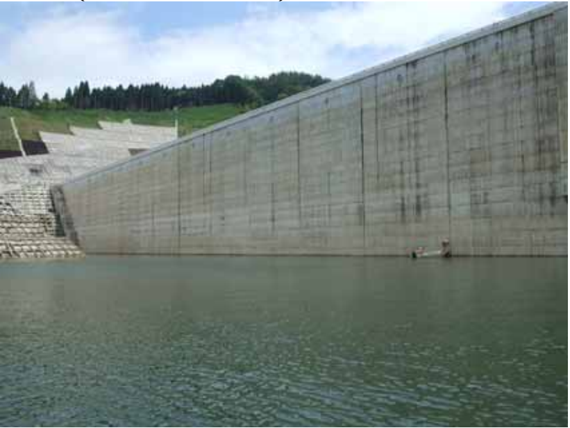
堤体巡視（堤体上流面船上巡視）
