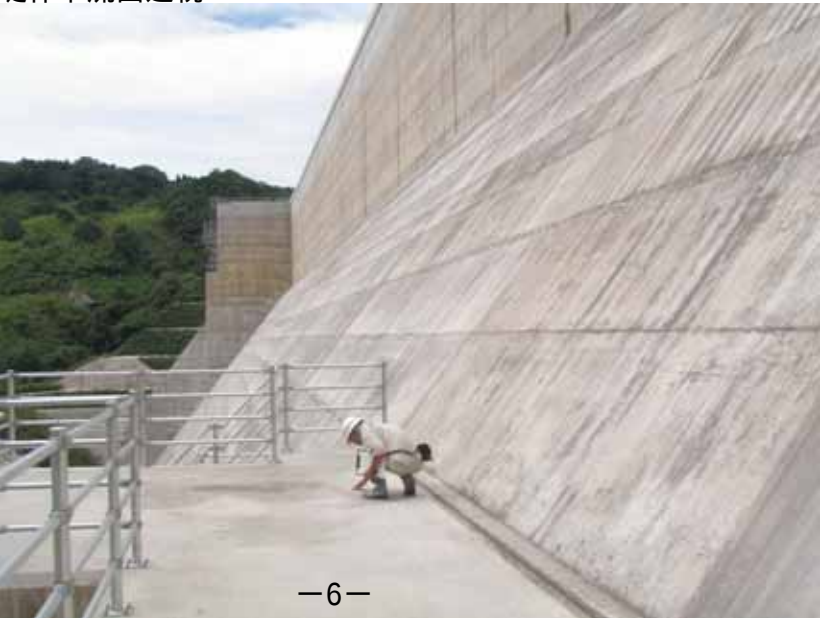
堤体下流面巡視
