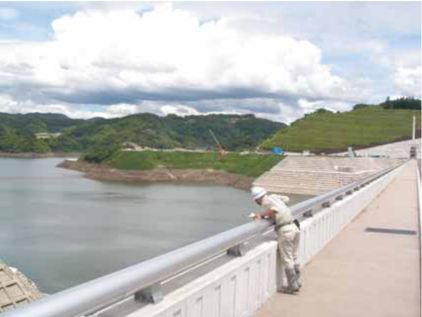
貯水池周辺巡視（貯水位 EL.196.0m）
