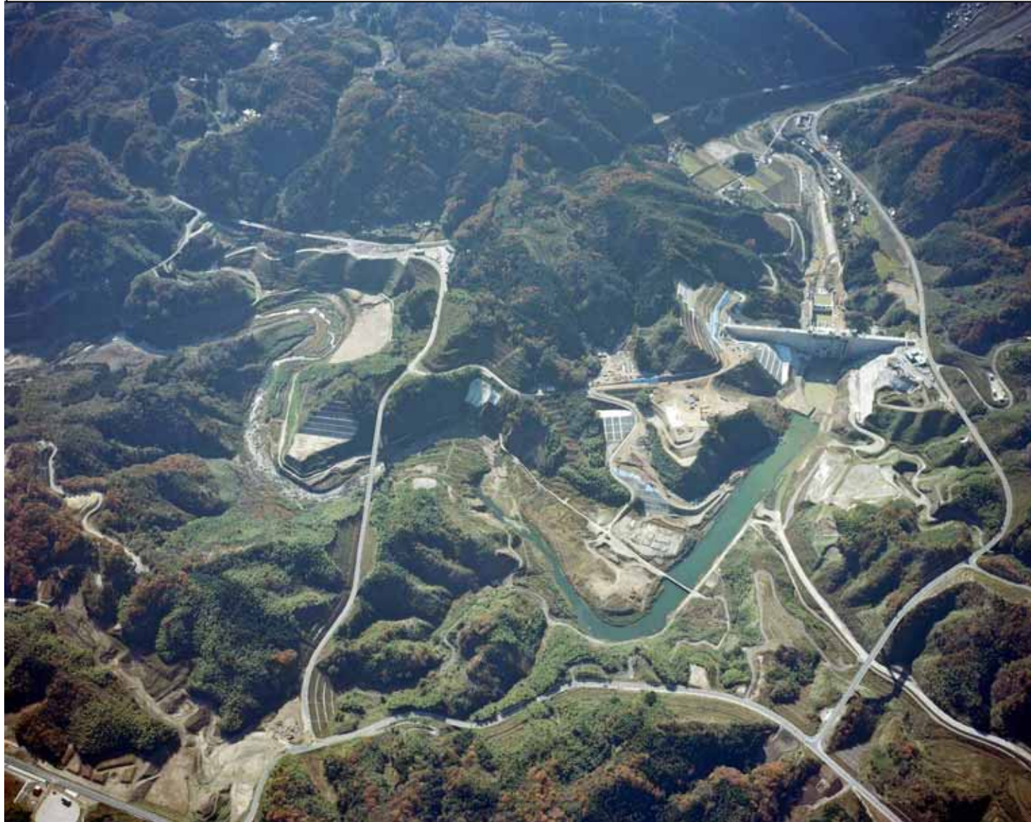
試験湛水開始直後(EL:154.5m)(H22.11.24 撮影)
