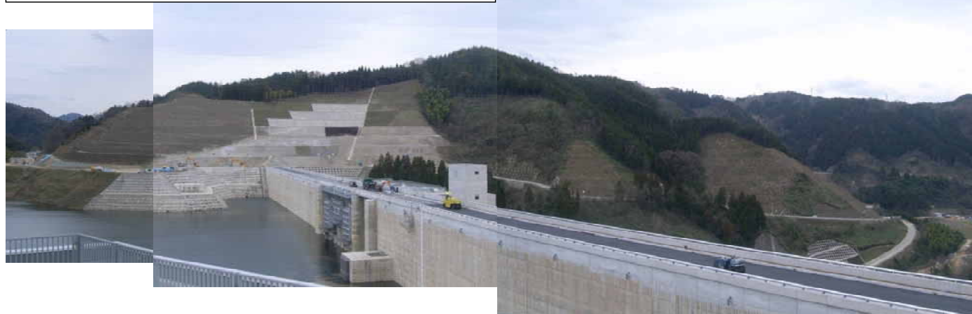
左岸側地山状況(EL:203.1m)(H23.4.7 撮影)
