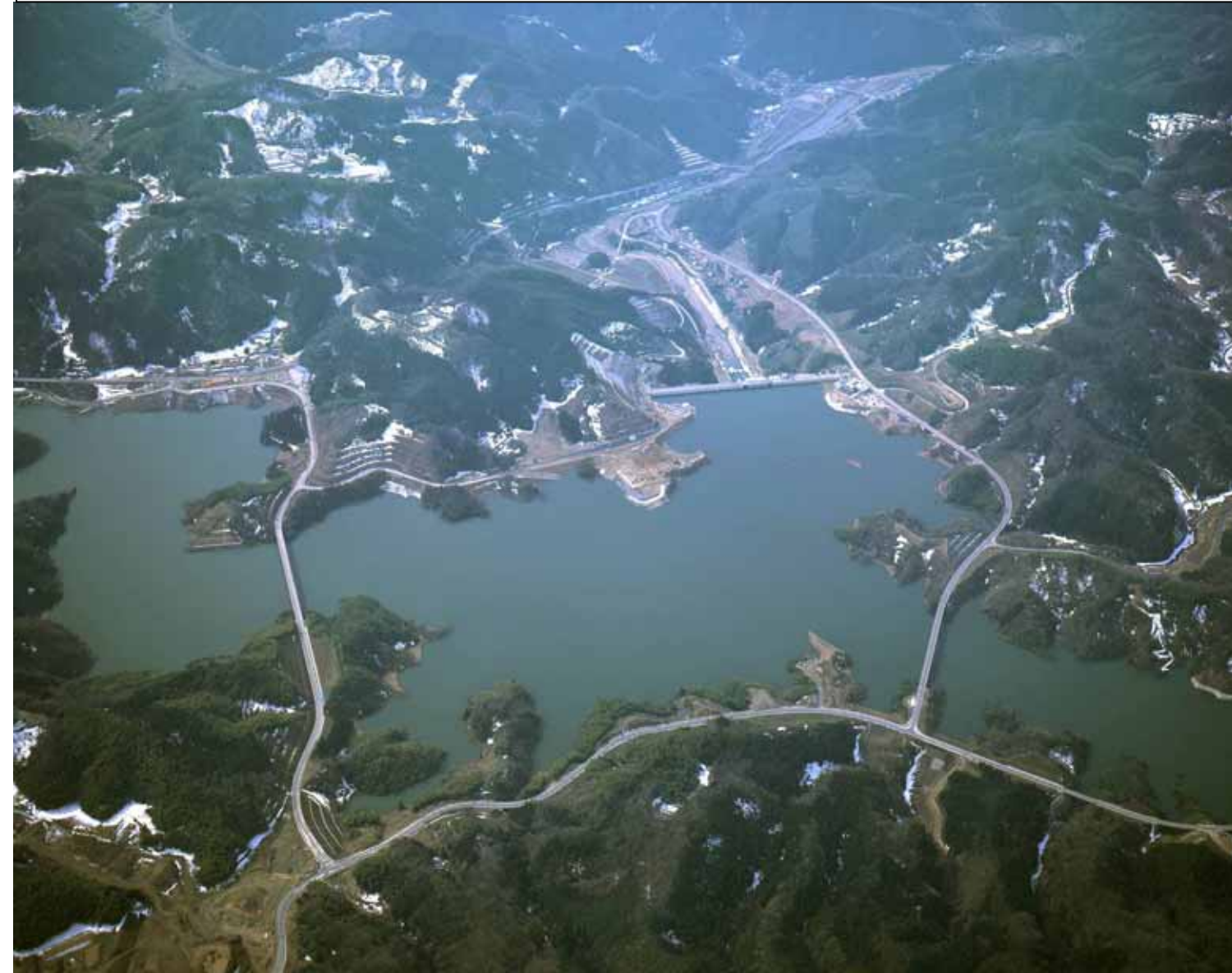
H22 試験湛水最高水位時(EL:212.8m)(H23.3.12 撮影)
