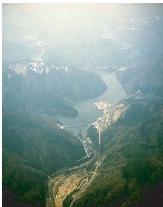
完成後の志津見ダム及び志津見湖の全景
