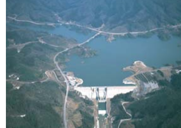
⑮-1 尾原ダム
