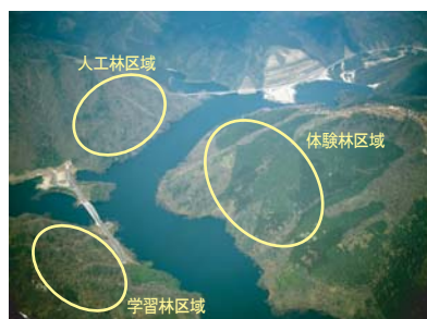
①-3 権現大橋付近の町有林の状況
