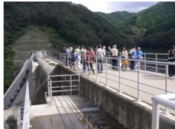
ダム巡視体験（イベント時）
