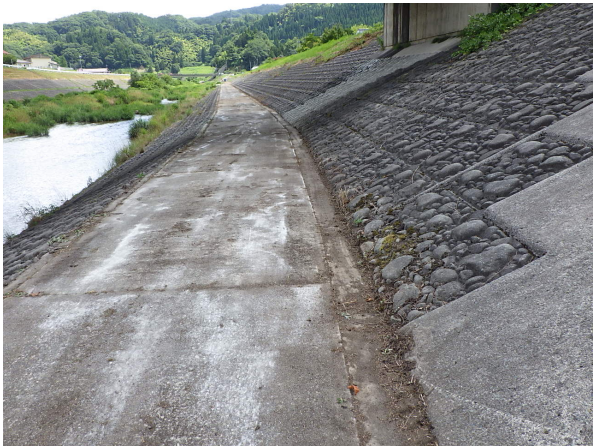
3. 護岸小段部 土砂撤去・除草 さつき会館前 神戸川 護岸小段部の土砂撤去・除草を実施し、親水性の確保を図った。
