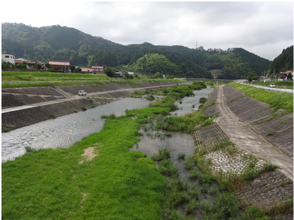
3. 護岸小段部 土砂撤去・除草 さつき会館前 神戸川 護岸小段部の土砂撤去・除草を実施し、親水性の確保を図った。
