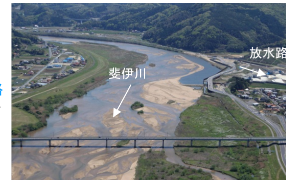
分流堰付近の斐伊川(H23.5)
