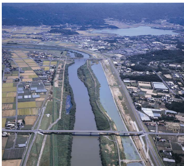
一次掘削(H15完了)
