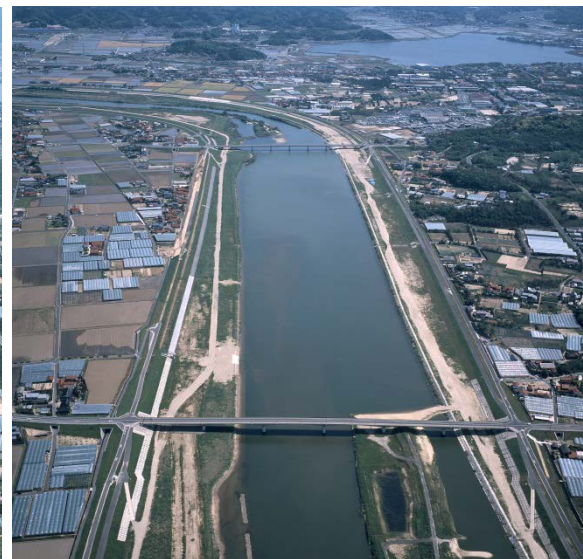
三次掘削(H21完了)
