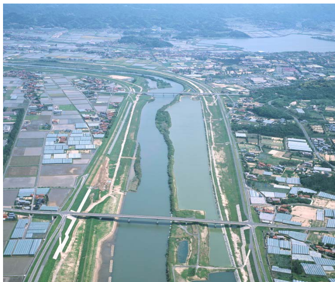
二次掘削(H19完了)
