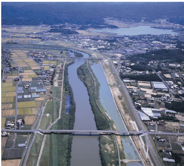
一次掘削(H15完了)
