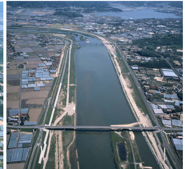
三次掘削(H21完了)
