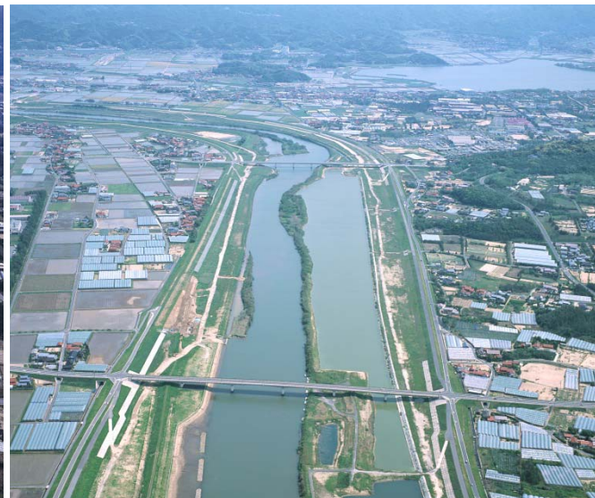
二次掘削(H19完了)
