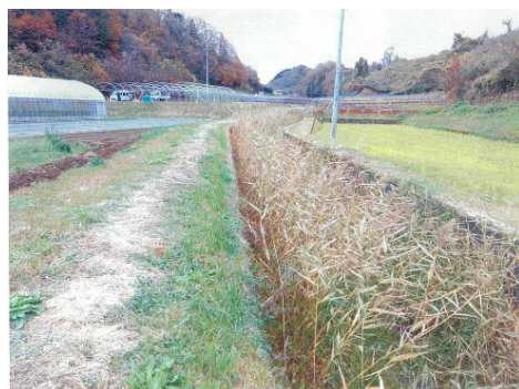
堆積土砂撤去前
