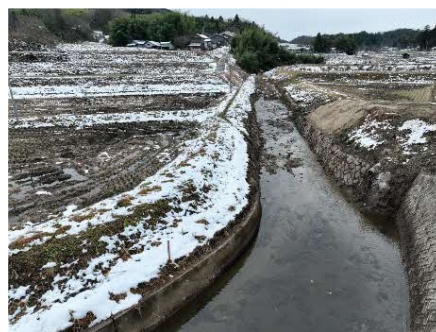
堆積土砂撤去後
