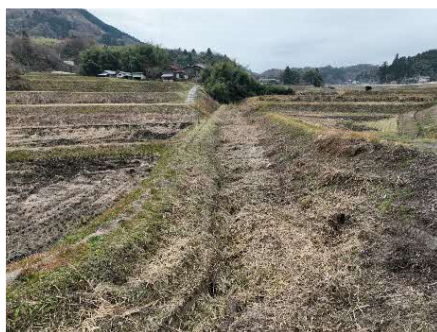
堆積土砂撤去前
