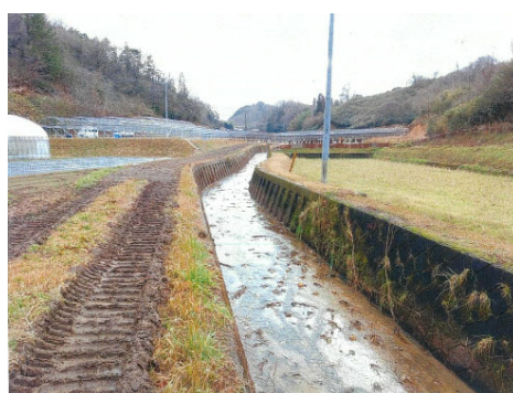
堆積土砂撤去後
