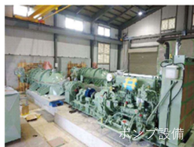
排水機場 整備状況
