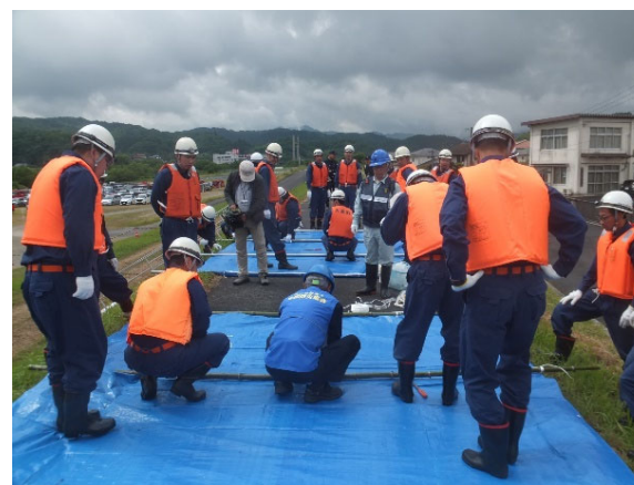
シート張り工
