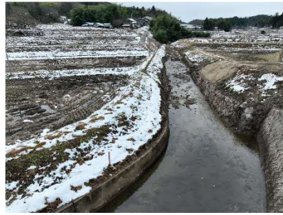
堆積土砂撤去後
