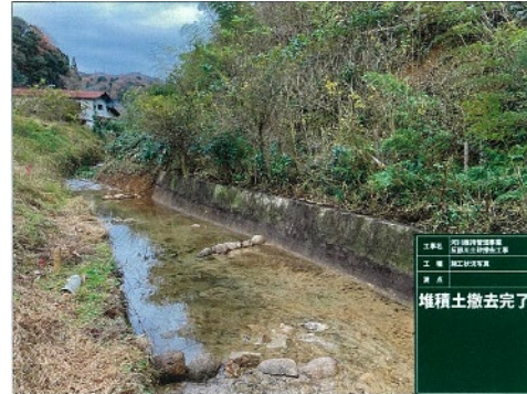
堆積土砂撤去後
