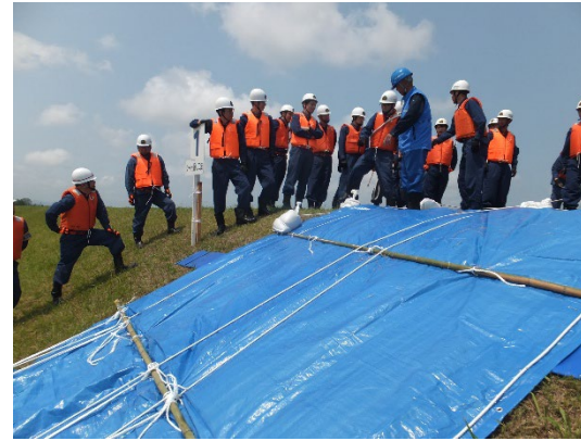
シート張り工
