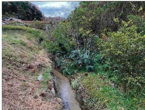
堆積土砂撤去前
