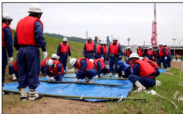
シート張り工
