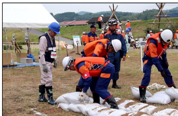
積み土のう工
