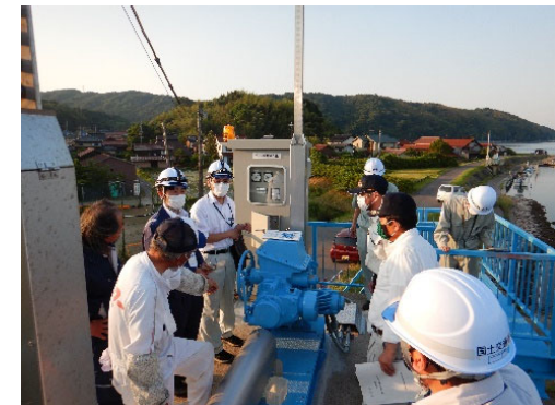
大井中溝川排水門 (R3. 6. 7)
