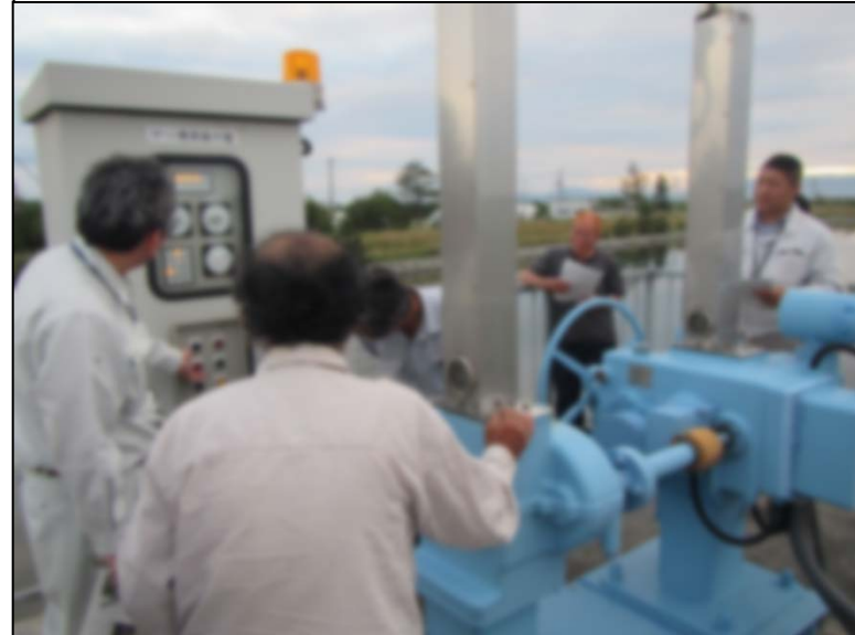
樋門操作の現地説明(米子市)
