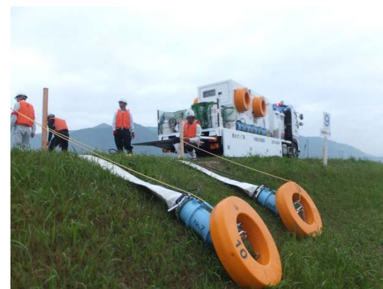
排水ポンプ車の設置訓練
