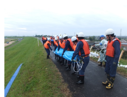
シート張り工法
