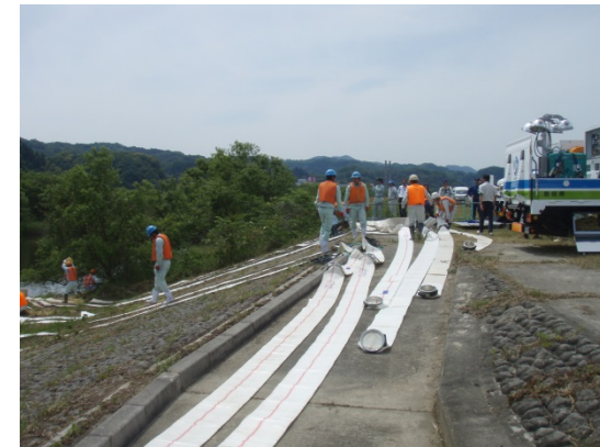
排水ポンプ車の設置訓練
