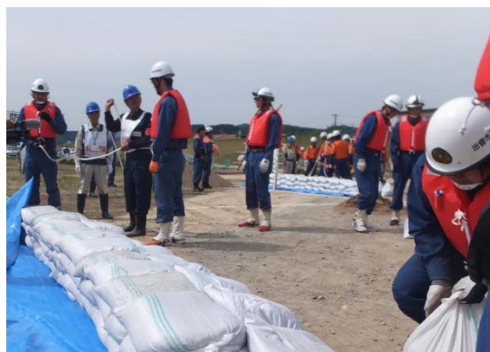
改良積み土のう工
