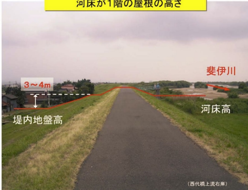
天井川の状況(斐伊川本川 西代橋上流右岸)
