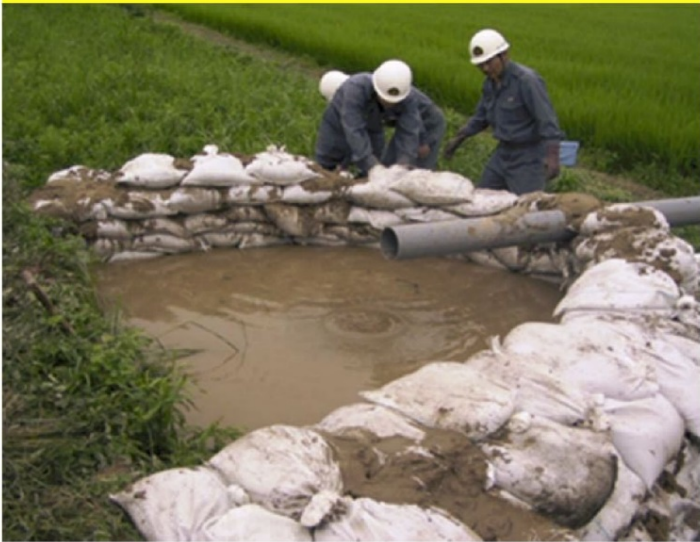
水防活動の状況(月の輪工の設置)
